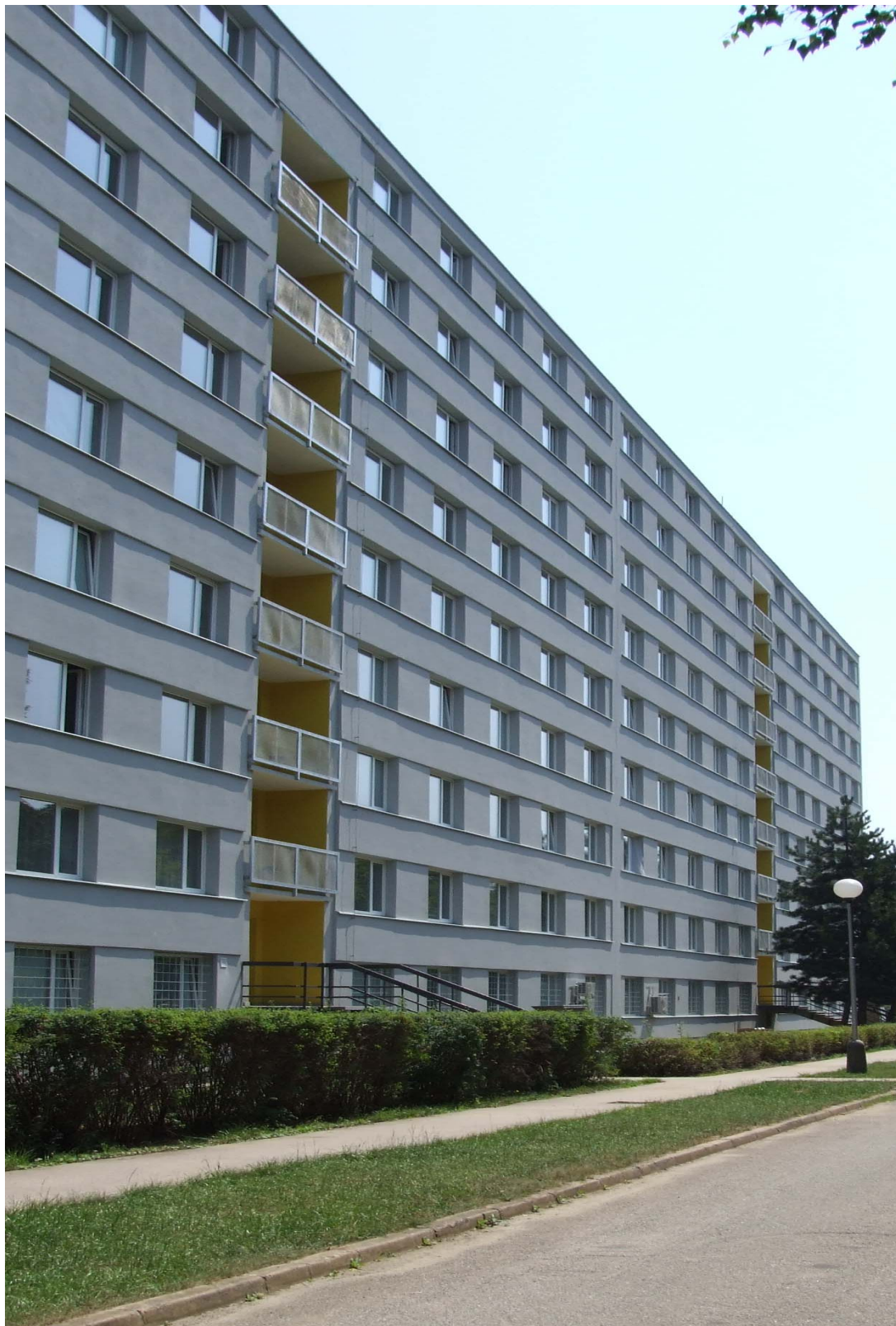
Nejnákladnější investicí v roce 2006 bylo zateplení a výměna oken objektu A02.
