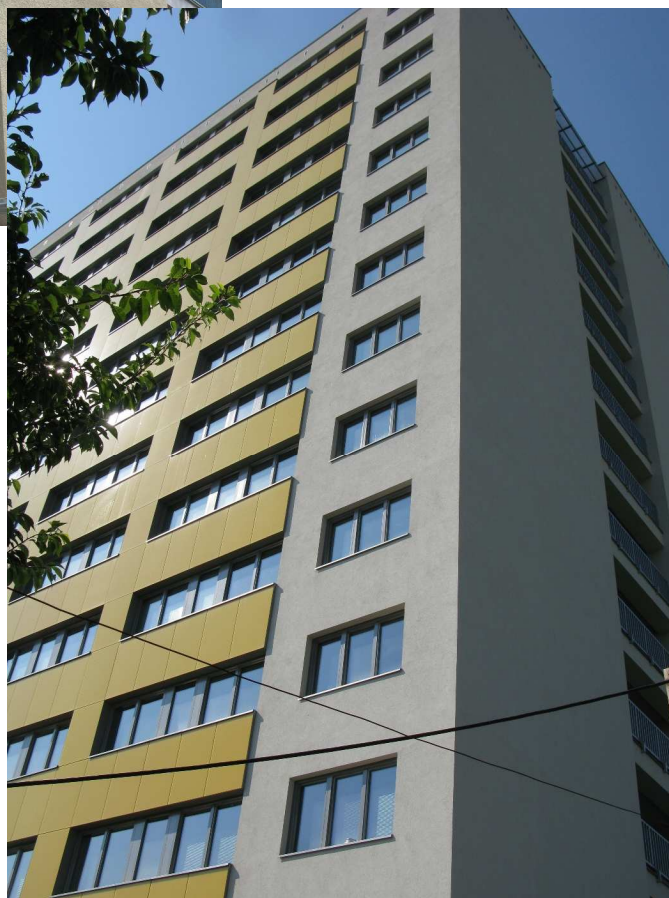
Pohled na Koleje Purkyňova 93 blok B04 před a po rekonstrukci.
